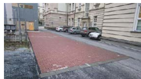
Opravy a rekonstrukce v areálu Pekařská
