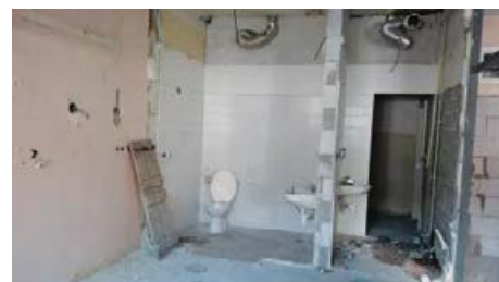
C – 4. NP – bourací práce
