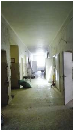
C 4. NP – rekonstrukce chodby
