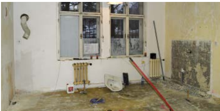
Sociální zázemí na ÚSL před rekonstrukcí
