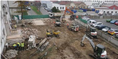
Průběh výstavby odpadového hospodářství
